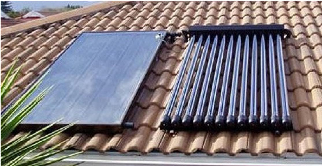
**Abbildung 3.16:** Solarkollektoren, links Flachkollektor rechts Röhrenkollektor
