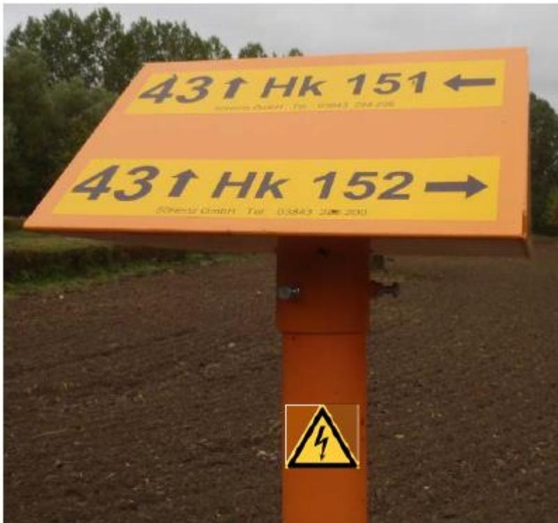
**Abbildung 6: Kennzeichnungspfahl über dem Hochspannungskabel (Quelle: 50Hertz)**
