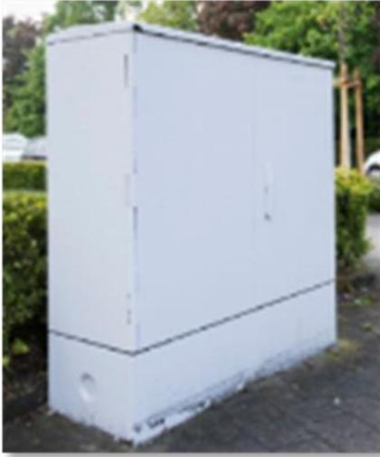
**Abbildung 3: Beispiel für einen Oberflurschrank zur Aufnahme von Erdungsschiene und Linkbox (Quelle: TransnetBW, Stand 2018).**
